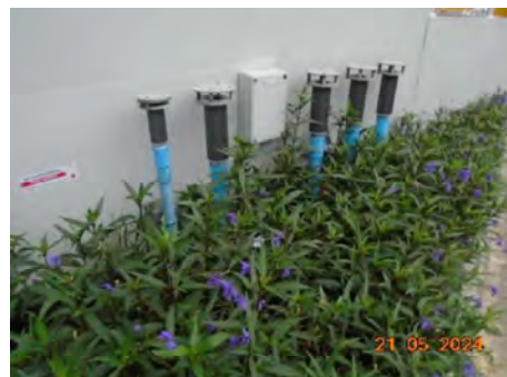
ภาพที่ 2.1-35 ระบบกำจัดก๊าซมีเทน
